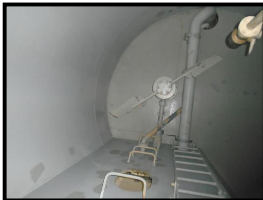
Figura 07 – Tanque de lama com agitador
