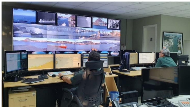
Figura 2 – Centro de Controle Operacional
