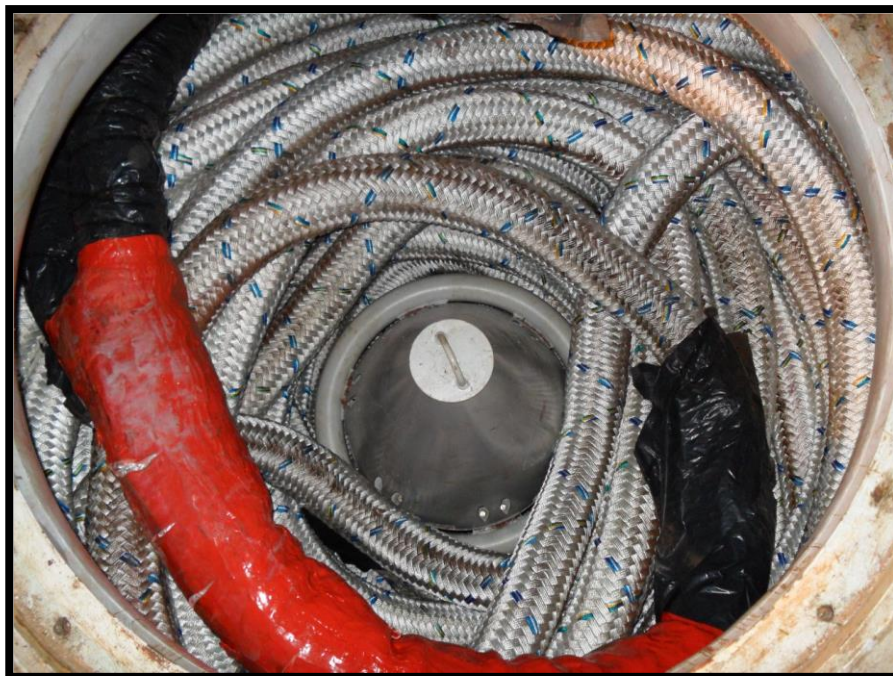
Figura 10 – Tanque de lama carregado com cabo de poliéster
